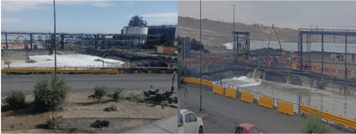
Figura 4.4 Estado de piscina posterior al aditivo utilizado en el Filtro N°3 (izquierda) y Filtro N°1 (derecha).
