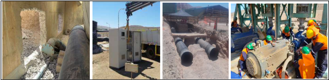
Figura N°4.2: Trabajos realizados por obras tempranas.
