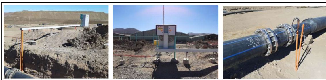
Figura N°4.17: Trabajos eléctricos en SX.
