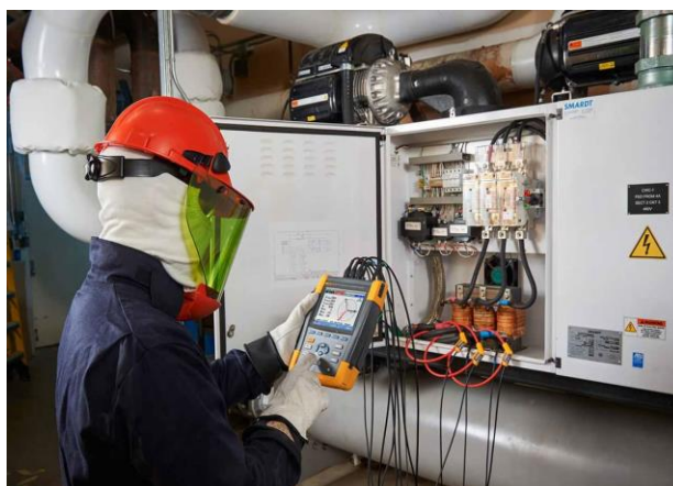
Figura 3.2 Forma segura de utilizar el analizador de red.
