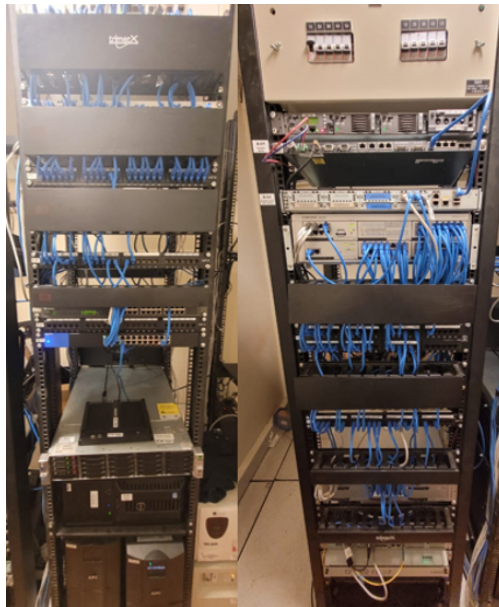
Figura 5.4: Rack de voz y datos normalizados.
