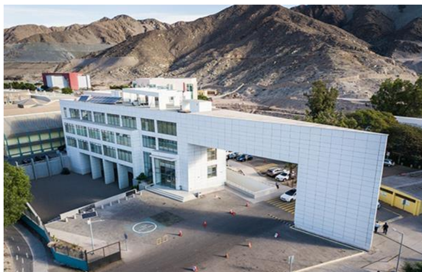
Figura 2.1 Edificio de rectoría de la Universidad de Atacama. Sede Copiapó.
