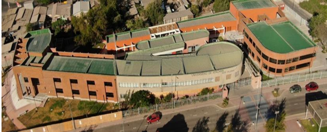
Figura 2.2 Sede Vallenar, Universidad de Atacama.
