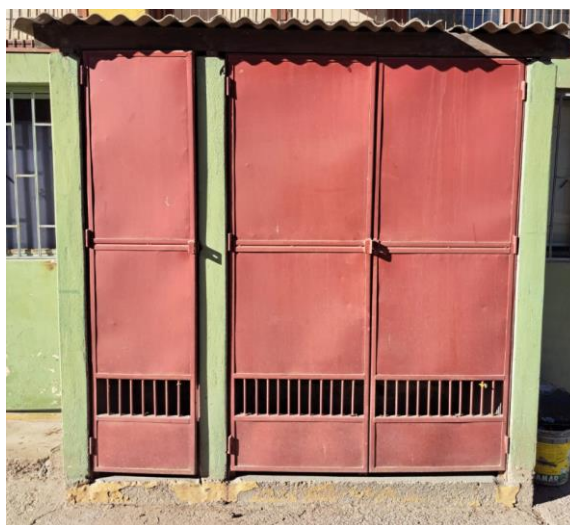
Figura N° 3.19: Vista general de bodega para instalación fotovoltaica.
