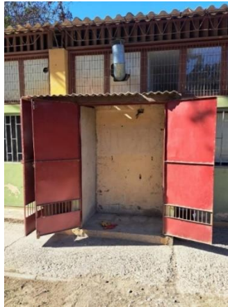
Figura N° 5.5: Bodega con materiales de laboratorio ya retirados.
