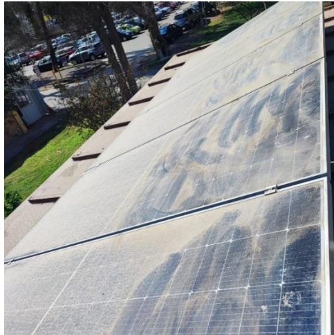
Figura N° 5.2: Polvo y secreciones pegadas en la superficie del módulo.
