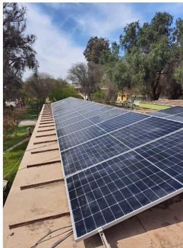
Figura N° 5.3: Módulos fotovoltaicos después de limpieza.
