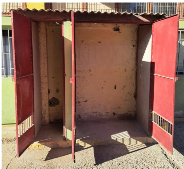
Figura N° 3.18: Bodega destinada para la instalación de elementos importantes.
