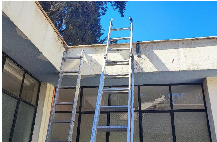
Figura N° 5.11: Escaleras de acceso a módulos solares.
