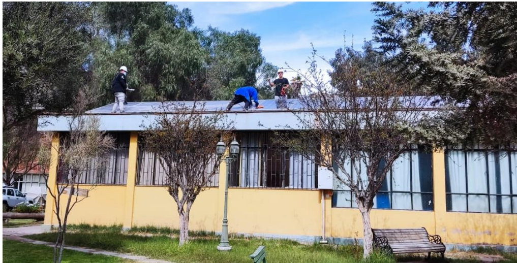
Figura N° 5.12: Limpieza de módulos solares.
