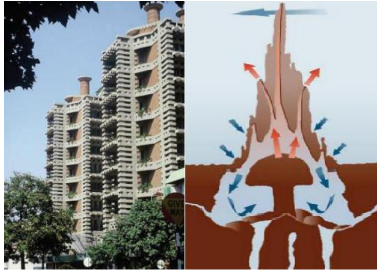
Figura III-III: El centro comercial EastGate Centre y el sistema de corrientes de los montículos de termitas de Zimbabwe
