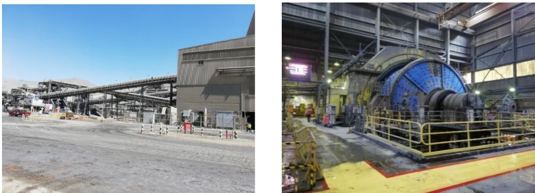
Fig. 3.1 Vista panorámica de la correa 3 y el molino SAG
