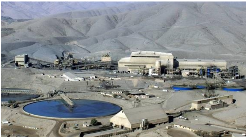
Fig.1.1 Vista de planta concentradora de minera candelaria
