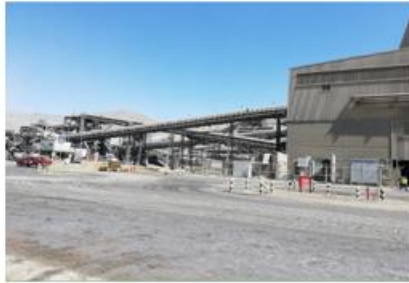
Vista panorámica de la correa CV-03
