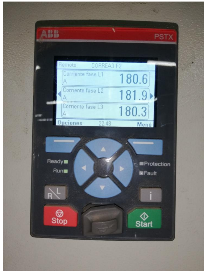
Fig.3.13 Funcionamiento del motor con carga
